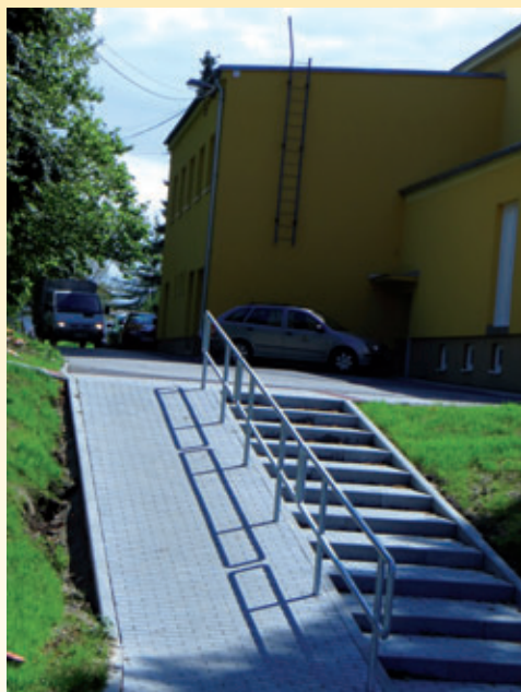
Zrekonstruované schodiště na ulici Družby
