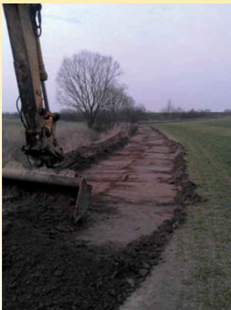
Výbudování spojovací komunikace ČOV – BULLY
