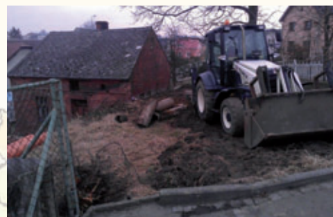
Oprava kanalizace v úseku Komenského – Hlavní
