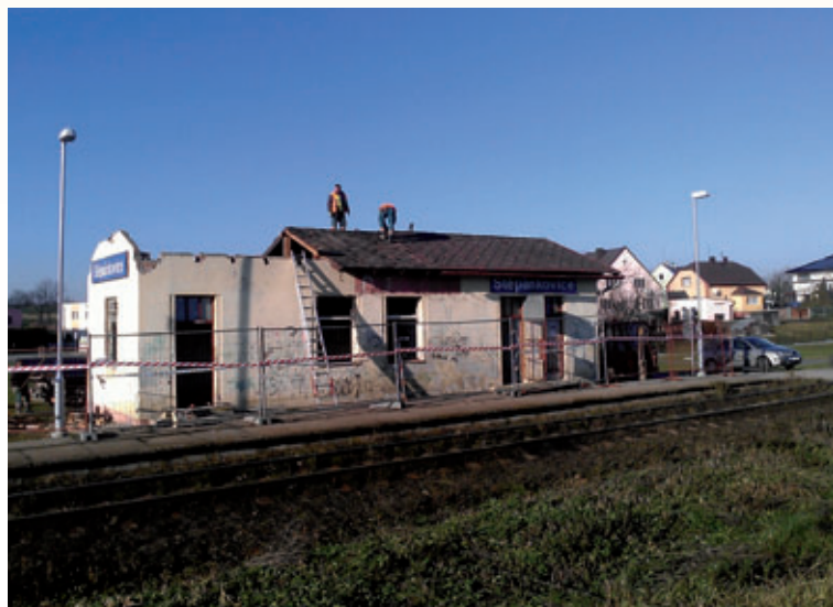
Demolice zdevastované vlakové zastávky
