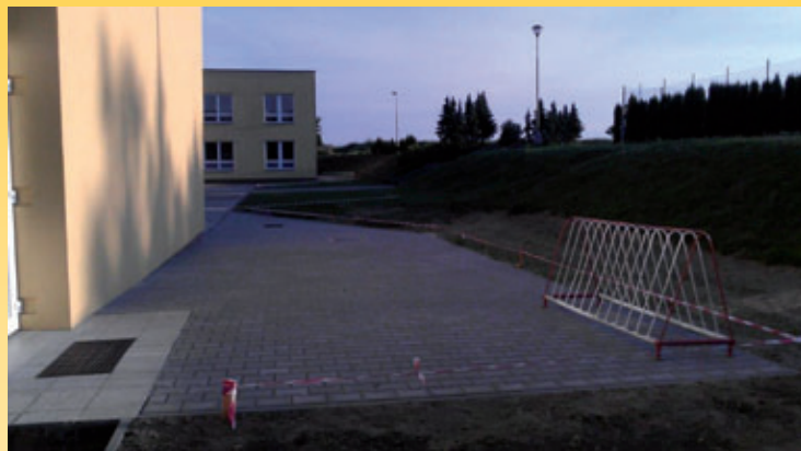
Pracovníci střediska služeb vybudovali přístup k tělocvičně v areálu školy
