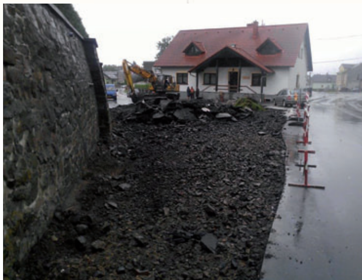
Začátek rekonstrukce křižovatky u kostela
