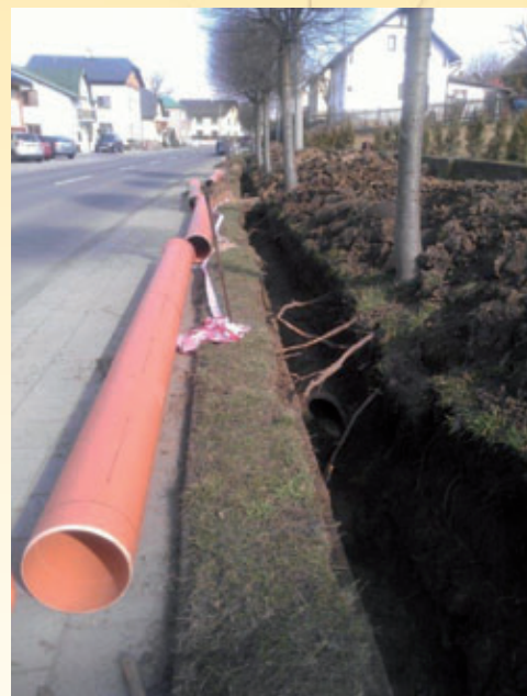
Oprava kanalizace na ulici Hlavní
