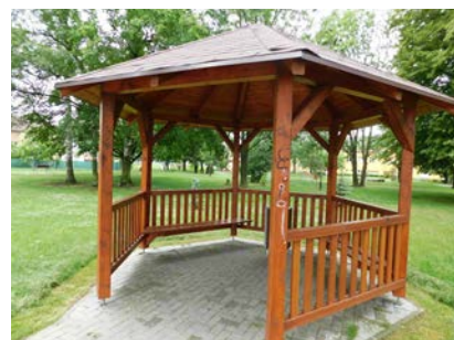
Vandalismus v obci
